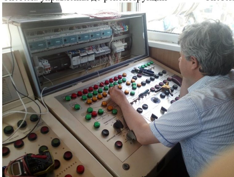
Распределённая АСУ ТП на базе приборов ПАО «ОВЕН»
