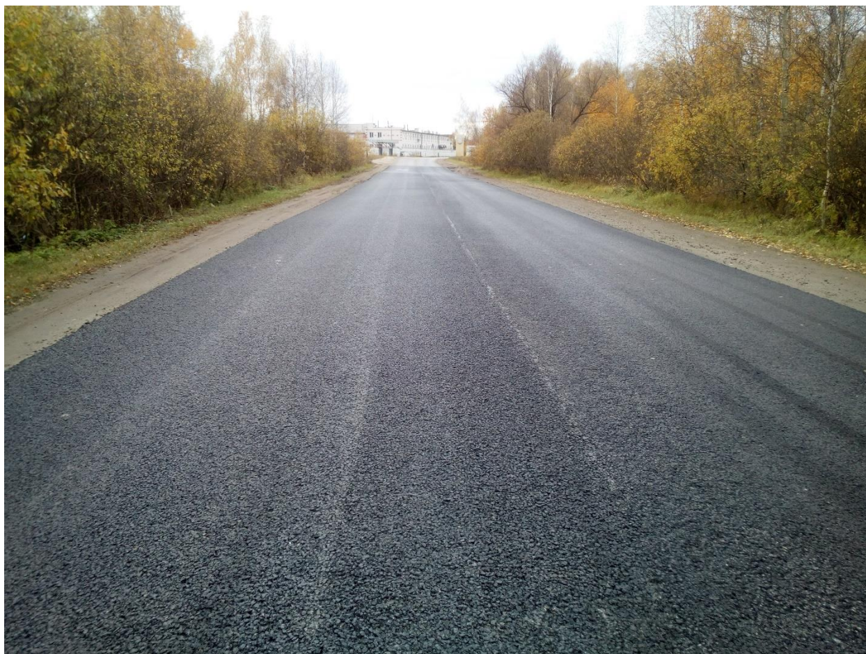
Первые пробные метры (200 м.) ЩМА20. Равномерность асфальта без промахов дозирования
